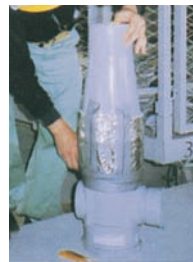
③上部側を防食テープで固定
