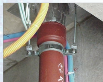
差込みRJ管支持例
