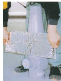
①離型紙をはがして集合管に巻き付ける
