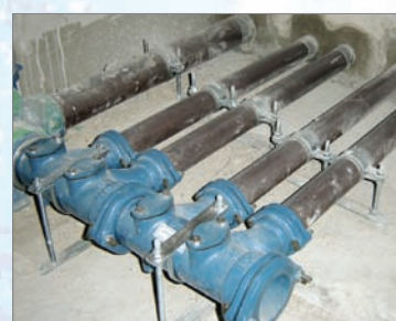
排水ヘッダー支持と排水管支持例
