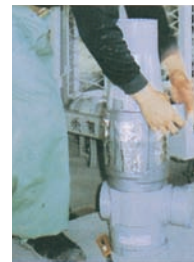
④下部側を防食テープで固定
